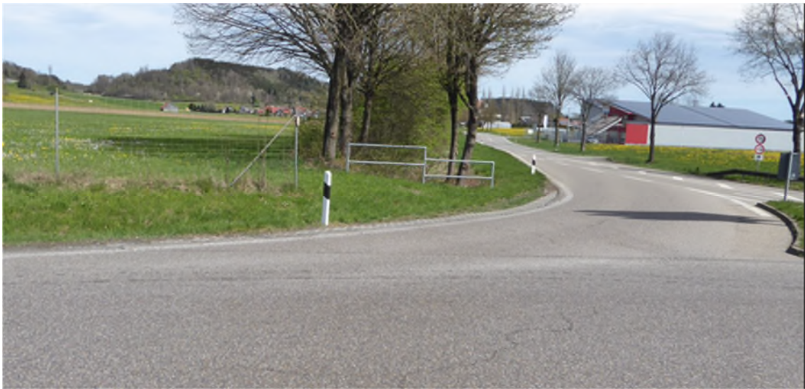
Bild 15 Einmündungsbereich mit Ausfahrkeil aus der L 260 in die Zufahrt zur BAB A 96. Der Ausfahrkeil soll zur Verbesserung der Sichtbedingungen und zur Geschwindigkeitsreduzierung zurückgebaut werden.
