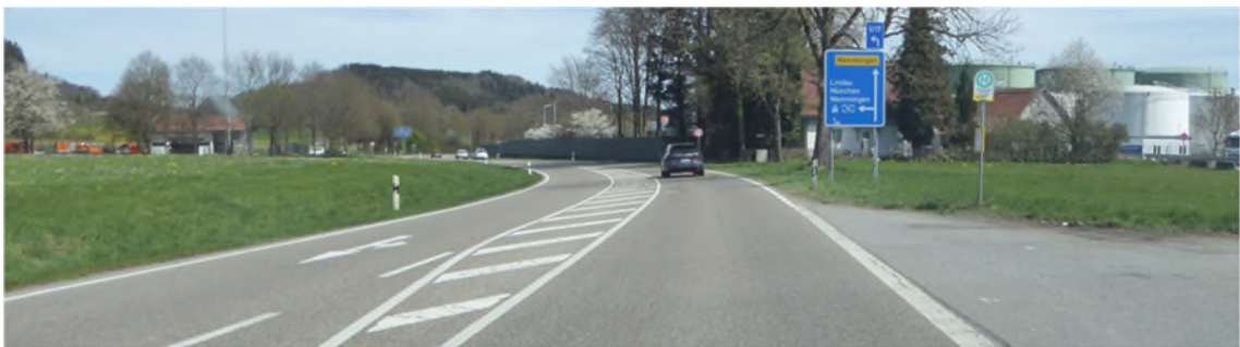
Bild 11 L 260 wieder in Richtung Altmannshofen mit vorhandener Bushaltestelle, die entfallen soll. Stattdessen ist hier in der Sperrfläche eine weitere Mittelinsel als Überquerungshilfe im Lageplan dargestellt, in den Unterlagen aber nicht weiter beschrieben.
