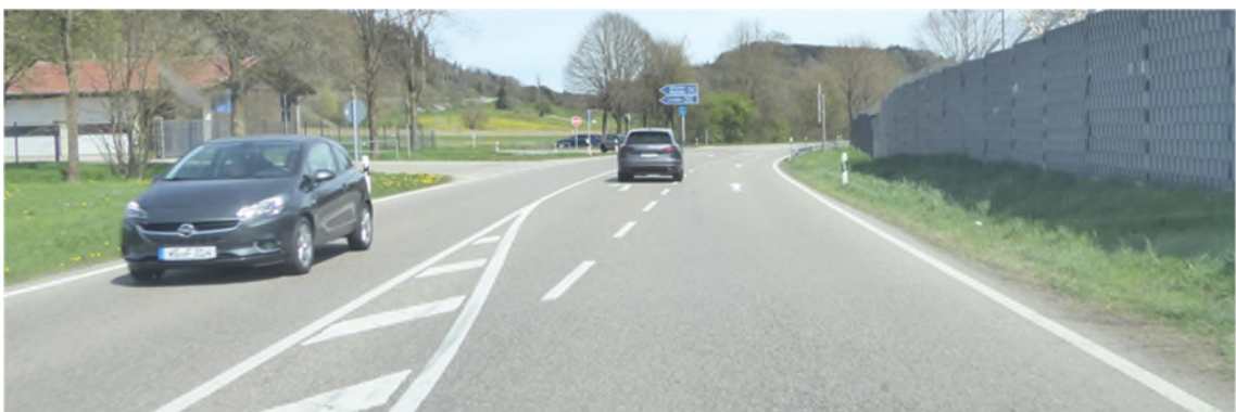
Bild 11 L 260 wieder in Richtung Altmannshofen mit vorhandener Bushaltestelle, die entfallen soll. Stattdessen ist hier in der Sperrfläche eine weitere Mittelinsel als Überquerungshilfe im Lageplan dargestellt, in den Unterlagen aber nicht weiter beschrieben.
