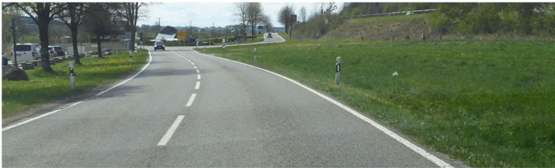
Bild 6 Nochmals L 260 in Richtung Niederhofen mit breiter Entwässerungs-/Versickermulde rechts und Einmündung K 8030 im Hintergrund
